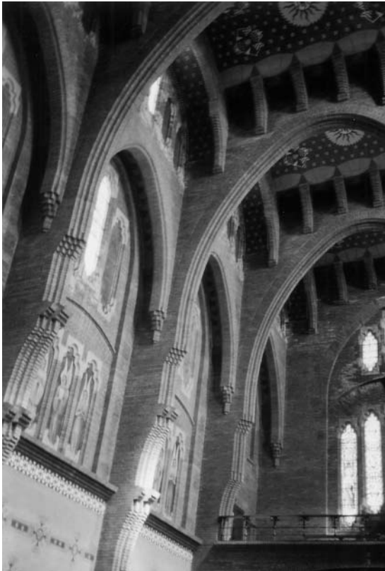
Estructura d'arcs equilibrats de l'Església de les Oblates.
